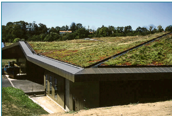
Abb. 4: Mit einem Gründach lassen sich bis zu 70 Prozent des anfallenden Niederschlags zurückhalten.
