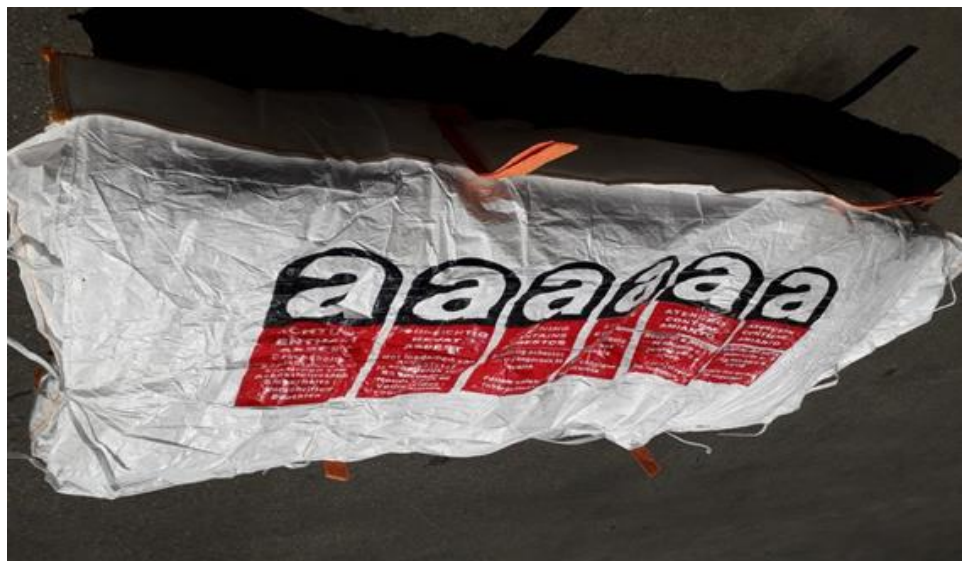
zugelassene Verpackung für Mineralfaserabfälle (links) sowie Asbestabfälle (rechts)
